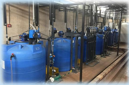
Помещение приготовления и корректировки химических растворов
